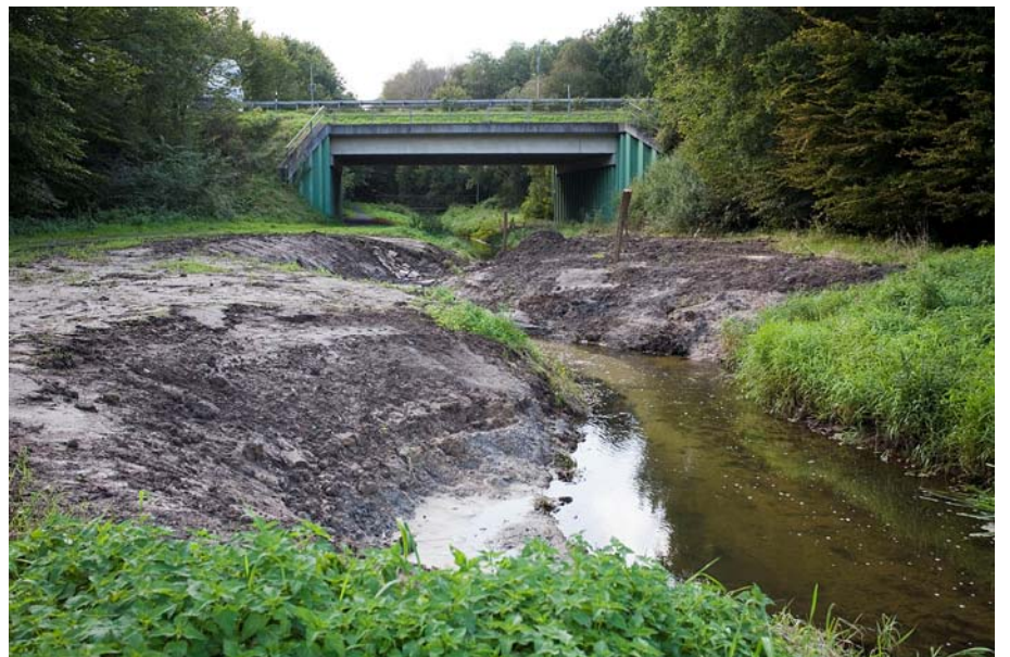
Abb. 6. 4732 Ösper Station 1.1 beim Umbau
